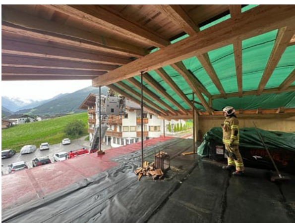
21.07.2024 Abgedecktes Dach, Scheibe
