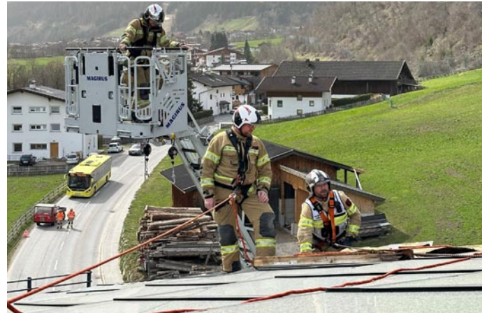
30.03.2024 Sicherungsarbeiten Dach, Scheibbs
